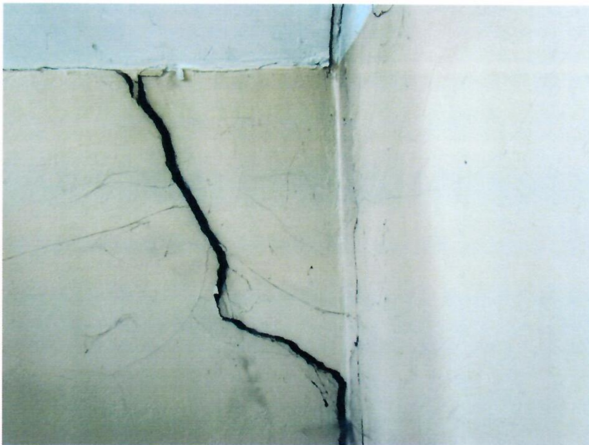
Zarysowanie ścian klatki schodowej na poz. +4,48 m
